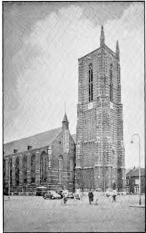
De Weertse toren na de stormramp van 1940. Duidelijk is te zien, dat ook één van de hoekpinakels is verdwenen.
