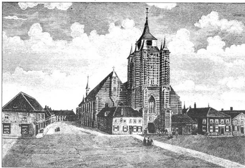
De St. Martinustoren vóór de verhoging van 1887-1889. De gebouwtjes tegen de toren aan -links een woonhuis van 1652 en rechts de stadsvleeshal van 1829- werden in 1882 gesloopt. Geheel links pand „Het Anker” en rechts café „Het Bruine Paard”. Op de achtergrond het oude pand van pensionaat St. Louis.
